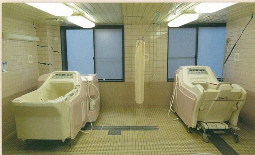
写真右側が車いすに座ったままスムーズに入浴が出来るので患者様も安心して入浴できます。左側はキャスター部を浴槽外部へ残したまま、リクライニングで入浴できる為、患者様の負担がなく入浴できます。
